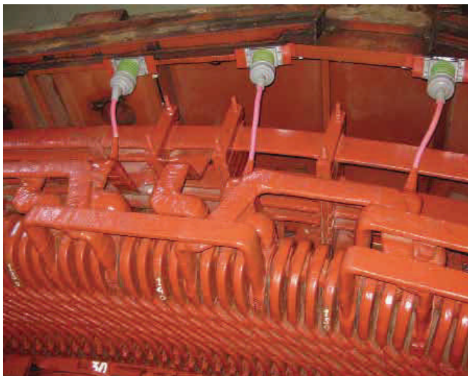
Instalación de acopladores capacitivos
